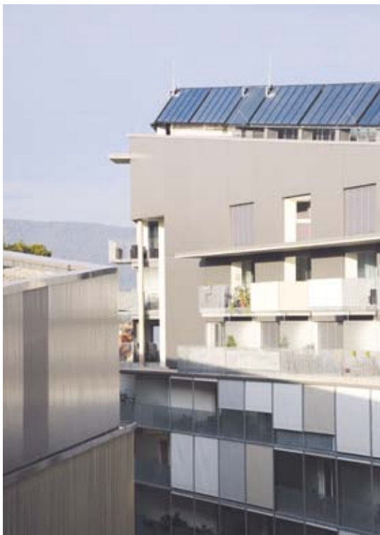
Eine Solaranlage erzeugt auf dem Dach Warmwasser
