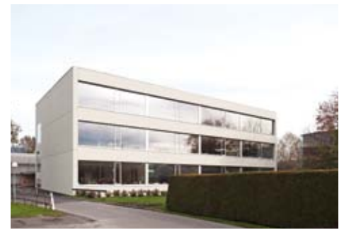
Die Volksschule nach dem Umbau
