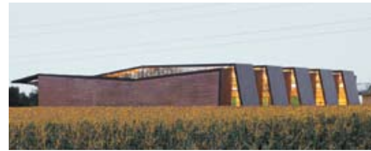
Foto: Obermayr Holzkonstruktionen
