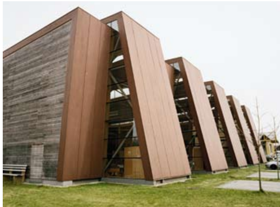
Glasflächen für Wärme- und Lichteintrag
