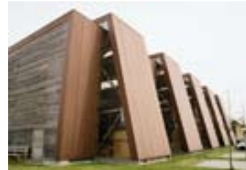
Staatspreis Elementfertigungshalle Obermayr Schwanenstadt / OÖ F2 Architekten
