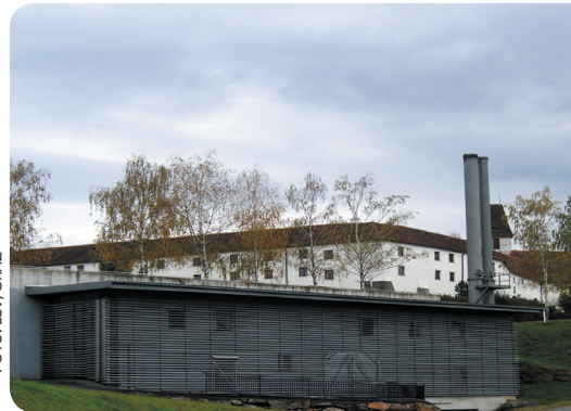
Heizwerk Schloss Seggau
